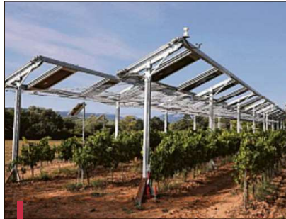
Avec ses ombrières intelligentes, Ombrea permet de moduler l'ombrage et de s'adapter aux besoins de plantes. /PH. CYRIL SOLLIER
